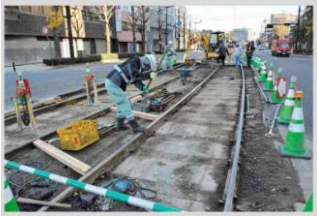
熊本市交通局は2日朝、昨年12月31日に市電が脱線した区間（熊本城・市役所前－花畠町電停間）で、レールの間隔を適正にする工事を始めた。復旧の時期は未定。市電は水道町－辛島町で運休が続いた。
